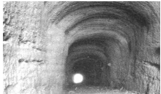
Figura 1.2 Mina de Daroca
