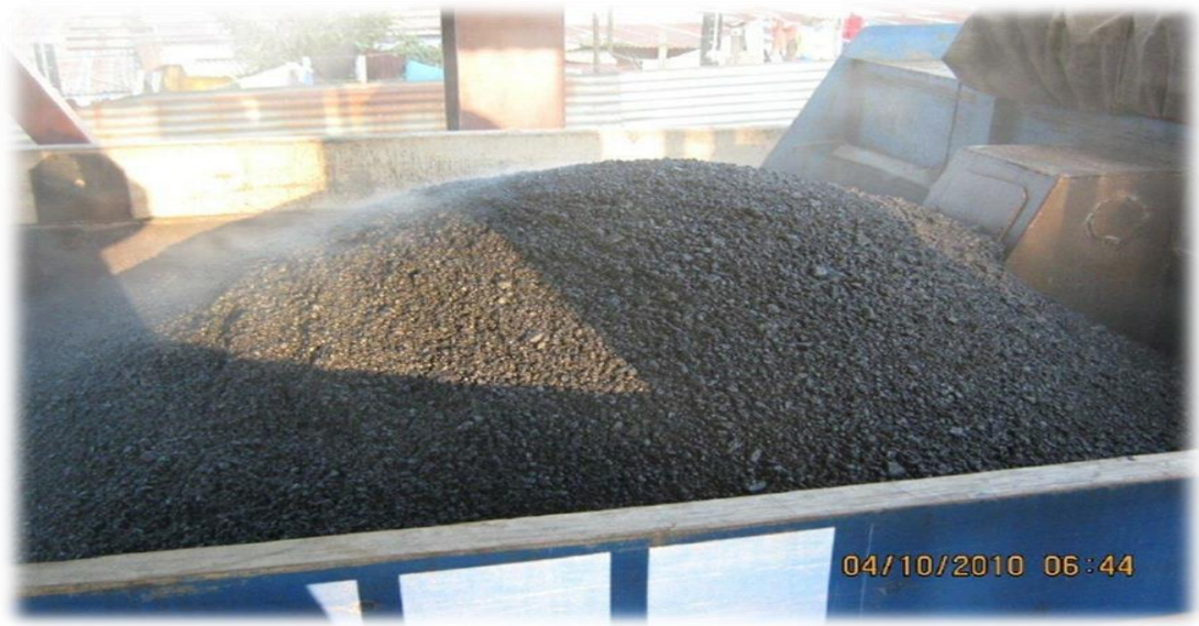
Figura 1.1 Mezcla asfáltica en Caliente. Fuente: Brigada de Construcción 3
