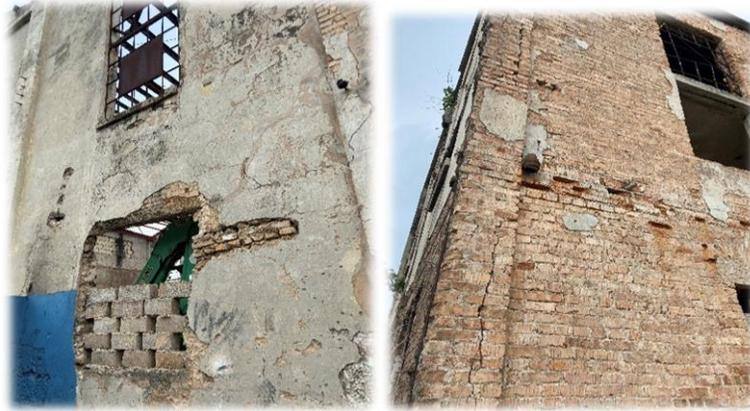
*Figura 2.10: grietas en muros y revestimientos. Fuente: Elaboración propia.*
