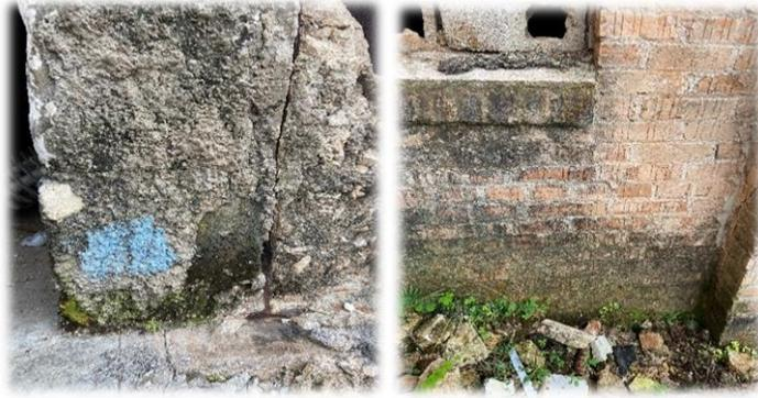
*Figura 2.7: Humedad capilar. Fuente: Elaboración propia.*
