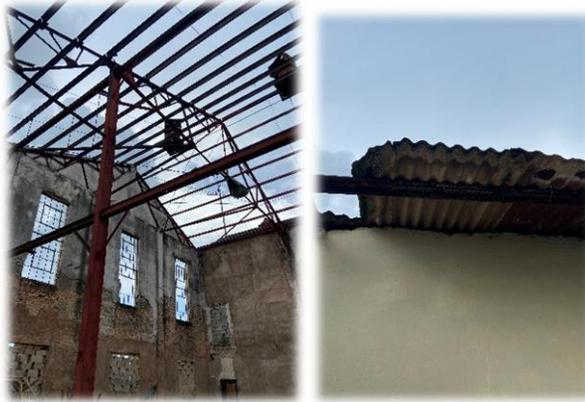
*Figura 2.5: Estado cubiertas de la nave y las oficinas. Fuente: Elaboración propia*
