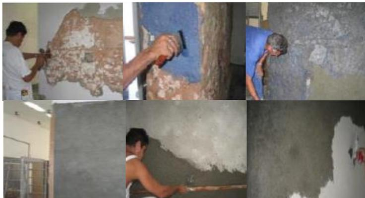
*Figura 7. Secuencia de acciones para muros desconchados humedad en la estructura. Fuente Roque, 2017.*
