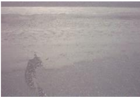
Figuras 2.2 y 2.3 Exudación: no se definen grados de severidad
