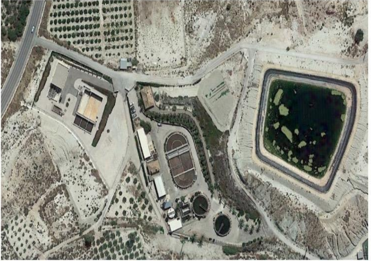
Figura-1: Vista general de la EDAR Abanilla y de la balsa de acumulación de agua tratada para riego (derecha)
