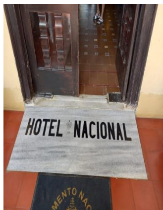
Rampa de mármol para solución del desnivel en el acceso del Lobby
