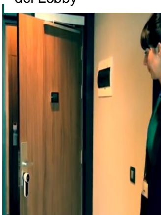
Puerta con brazo de apertura automática con botón de accionamiento manual.
