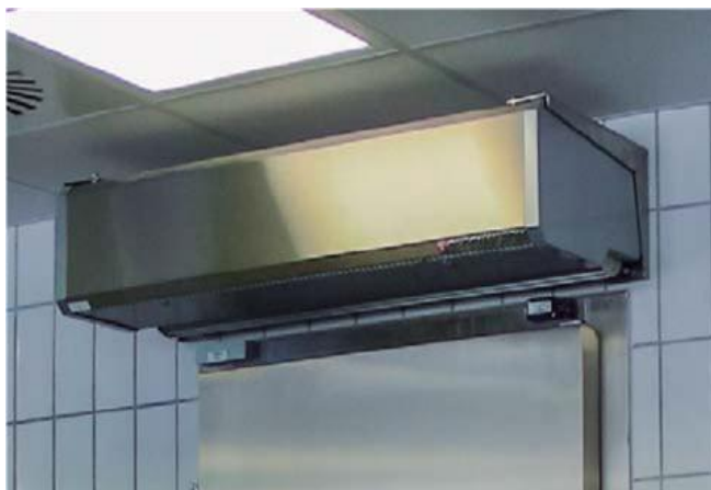
Figura F4: Cortinas de aire comerciales e industriales para puertas de cámaras frigoríficas (opcional).
