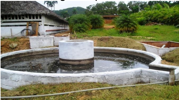
Anexo 6: Figura 5; Biodigestor de cúpula fija con laguna de compensación sobre o biodigestor. (Sánchez et al. , 2011)
