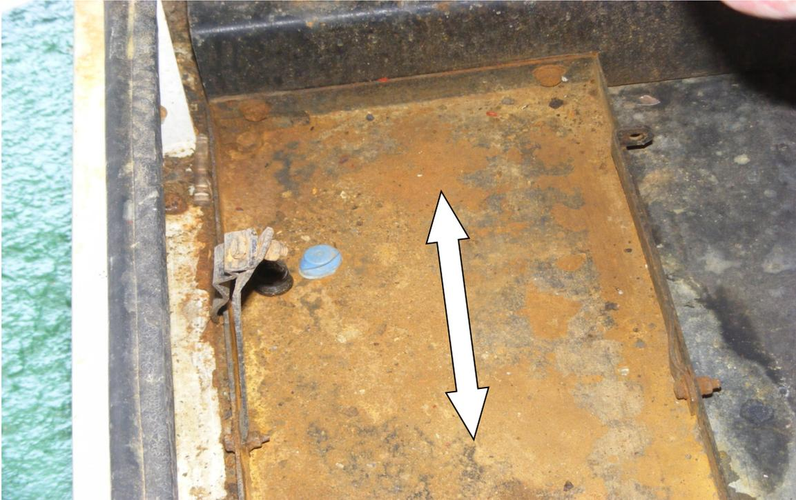
**Figura 2.6: Zona donde hay retención de humedad, depósitos y agua.**
