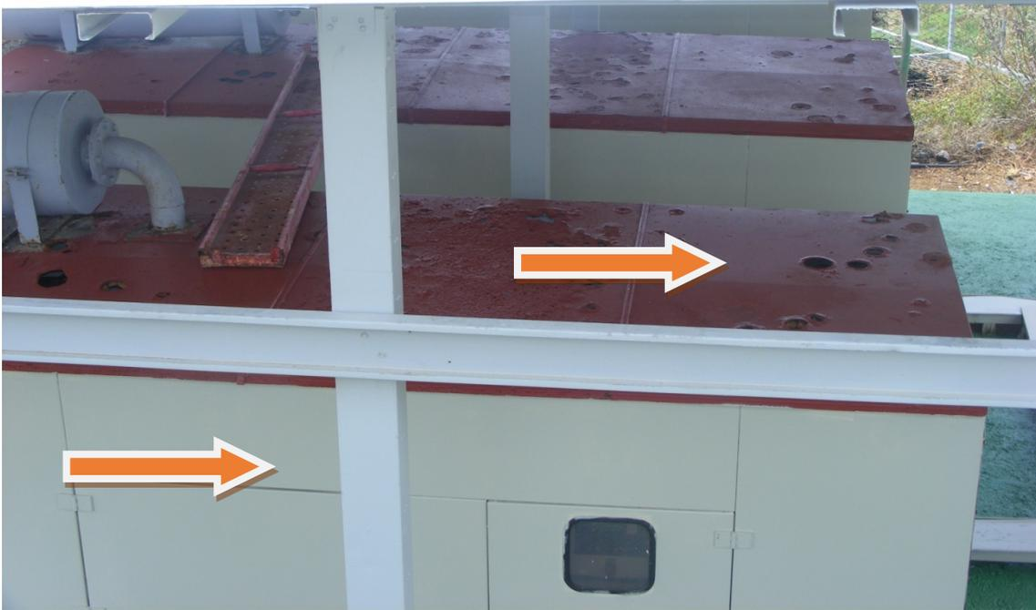
**Figura 2.14:** Aplicación de cera impermeabilizante.
