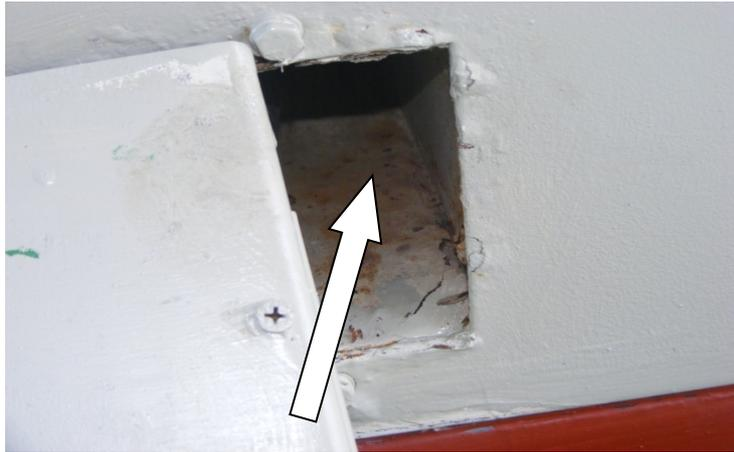
**Figura 2.1: Componentes inaccesibles para el tratamiento anticorrosivo.**
