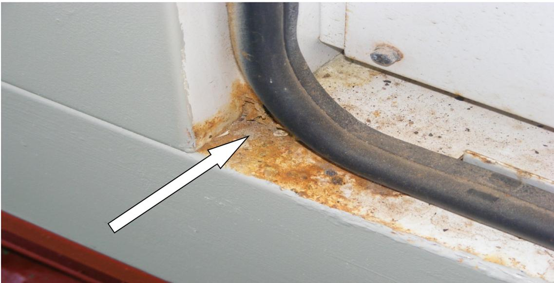
**Figura 2.5: Zona donde hay retención de humedad, depósitos y agua.**
