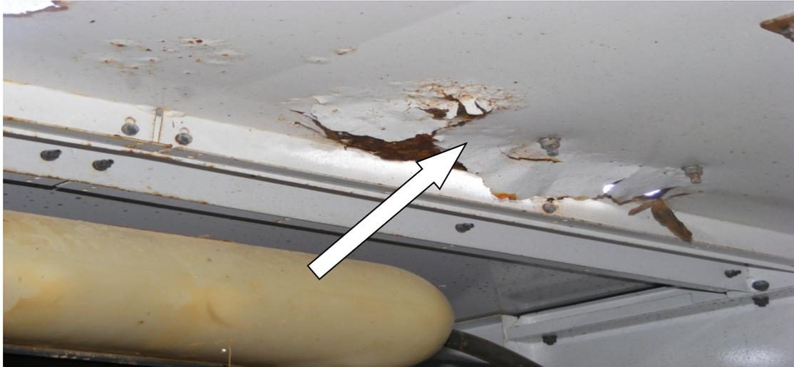
**Figura 2.13: Corrosión interfacial.**
