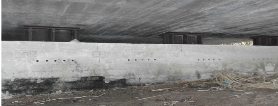
Figura 2.4 Vista de los apoyos articulados. (Tomada por el autor)
