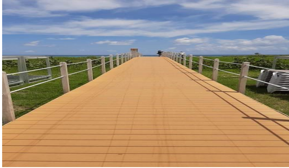
Figura 2.16- Pasarela peatonal de WPC del Hotel Internacional
