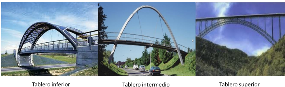
Figura 1.3-Tipos de pasarelas peatonales en arcos (Elaboración propia).
