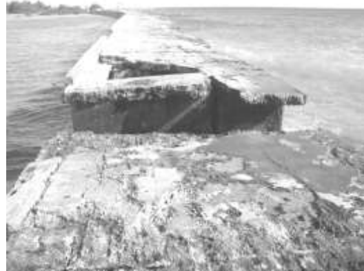
Foto 11. Cajón con las caras laterales partidas.
