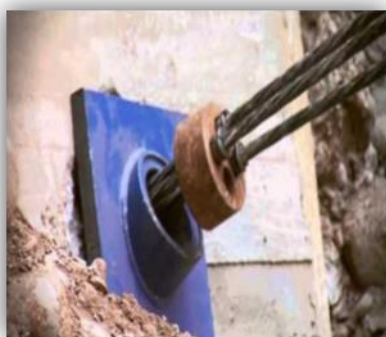
Fig 1.3 Anclaje activo(Argila, 2018).
