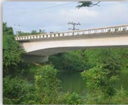
Fig 1.9 Puente Cuyaguaje (Arestuche & Pérez, 2009).
