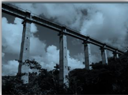
Fig 1.11 Puente del Ferrocarril Central sobre el río Canímar (Arestuche & Pérez, 2009).
