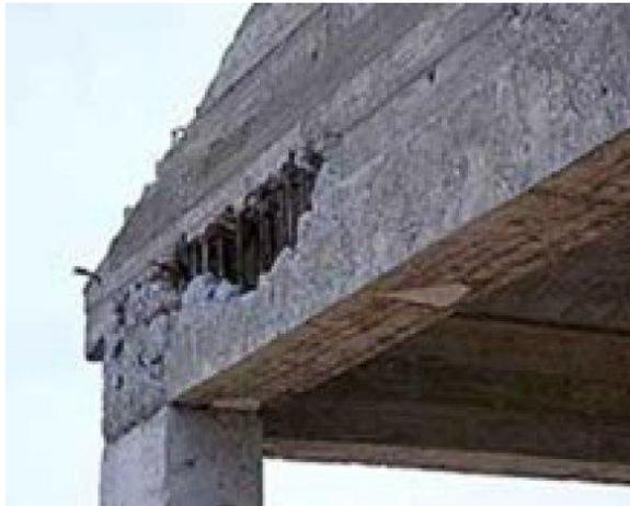
**Fig.13. Ejemplo de Desprendimiento**
