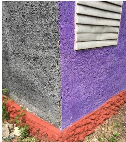
**Fig.12. Ejemplo de Grieta vertical**
