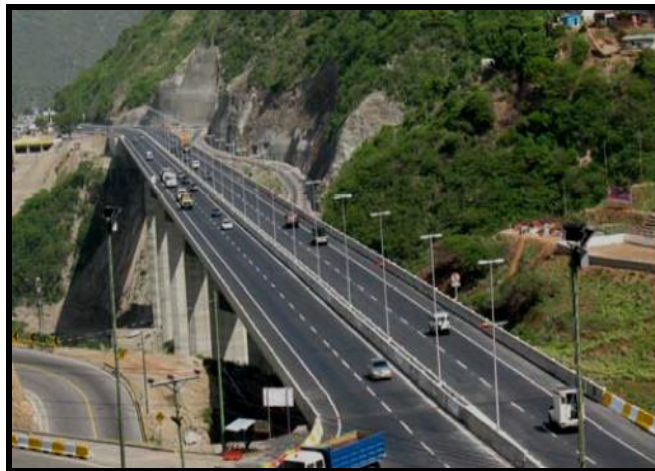
Figura 1.13. Apertura del tráfico
