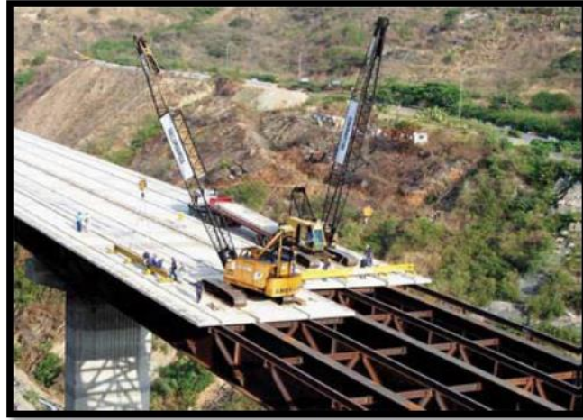
Figura 2.12: Colocación de la losa de hormigón.
