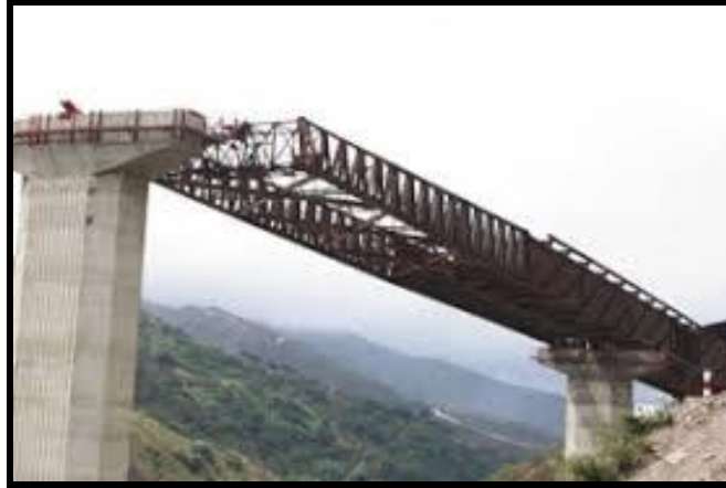
Figura 3.2: Nariz de lanzamiento al llegar a la pila
