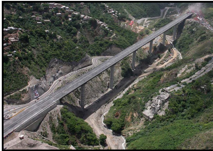
Figura 1.10. Viaducto Caracas-La Guaira, Venezuela.
