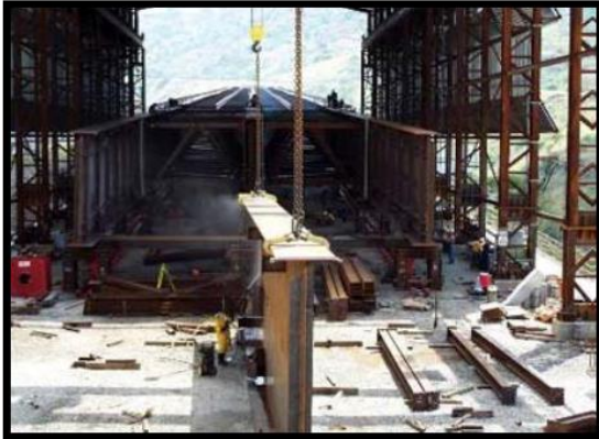
Figura 2.8: Pre ensamblaje de la primera Sección.
