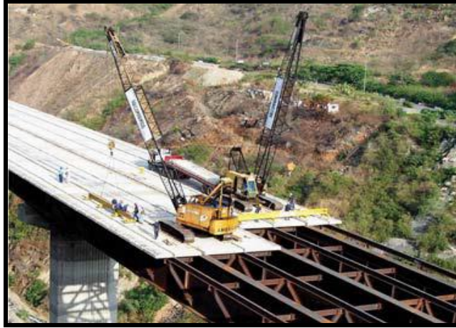
Figura 1.12. Colocación del tablero
