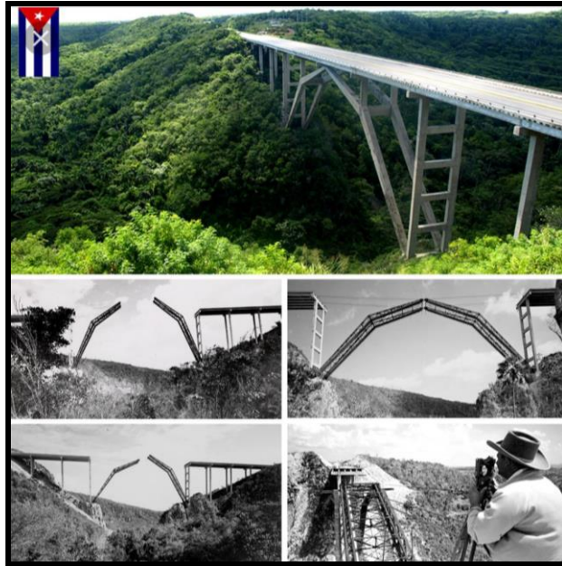
Figura 3.5: Puente de Bacunayagua, maravilla de la ingeniería civil cubana
