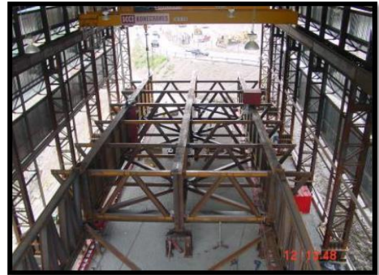
Figura 2.9: Pre ensamblaje de la nariz.
