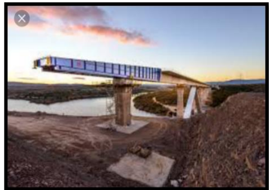
Figura 2.7: Viga de Lanzamiento
