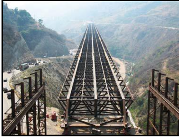
Figura 1.11. Lanzamiento de la estructura
