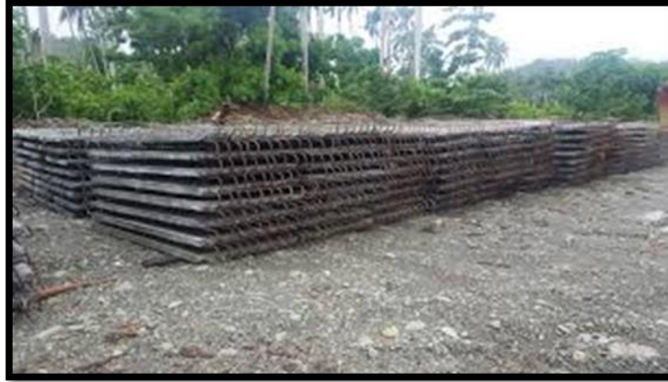
Figura 2.4: Losas de tablero de hormigón
