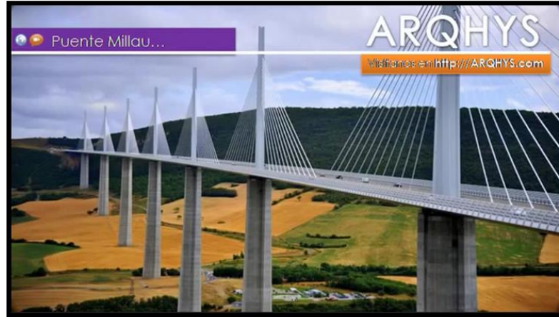
Figura 1.14. Puente de Millau, Francia.
