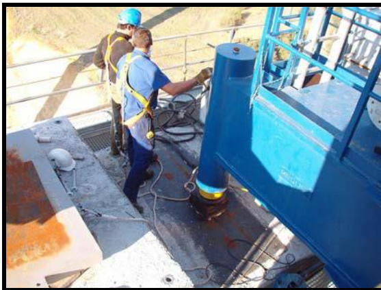
Figura 3.3: Detalle del gato frontal y el gato en la nariz
