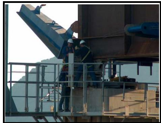
Figura 3.4: Operación de paso de pila y repliegue de patines
