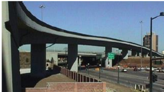
Figura 1.4. La rampa de Park Avenue en el centro de Denver, Colorado.
