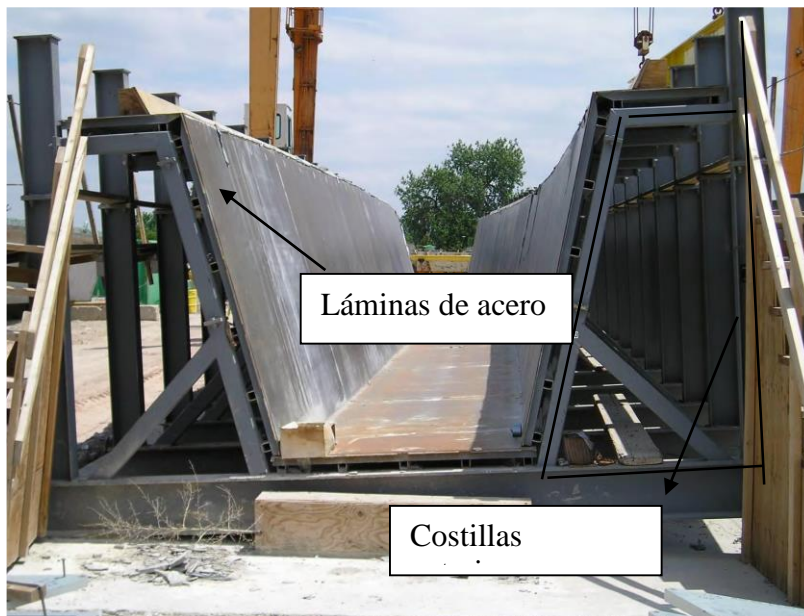
Figura 1.9 Molde de viga. Cama inferior. Fuente:(William N. Nickas, 2010)
