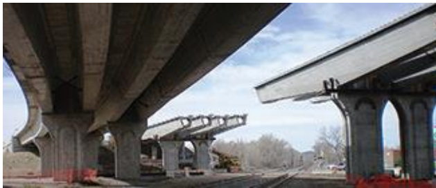
Figura 1.7. El viaducto I-5 Trinidad (Colorado) presenta vigas escalonadas que brindan espacio libre de 80 m sobre un patio de ferrocarril. Foto: PCI
