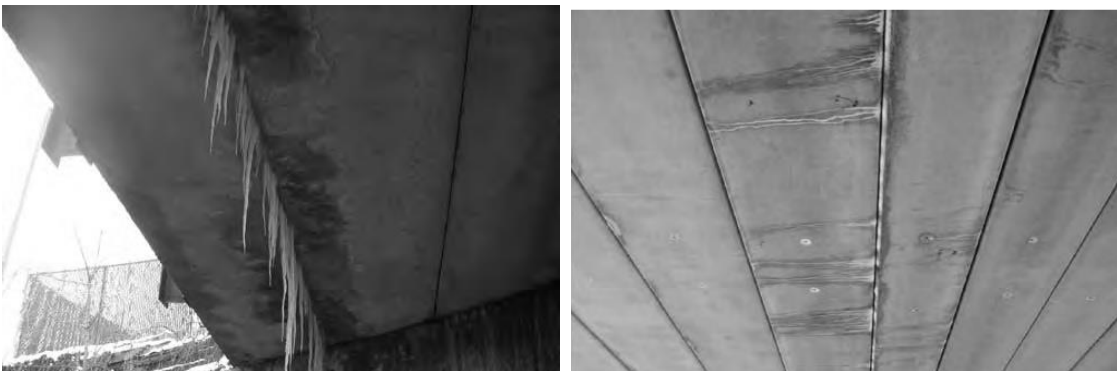
Figura 1.3 Puente con vigas cajón adyacentes. Fuente:(NCHRP, 2009)
