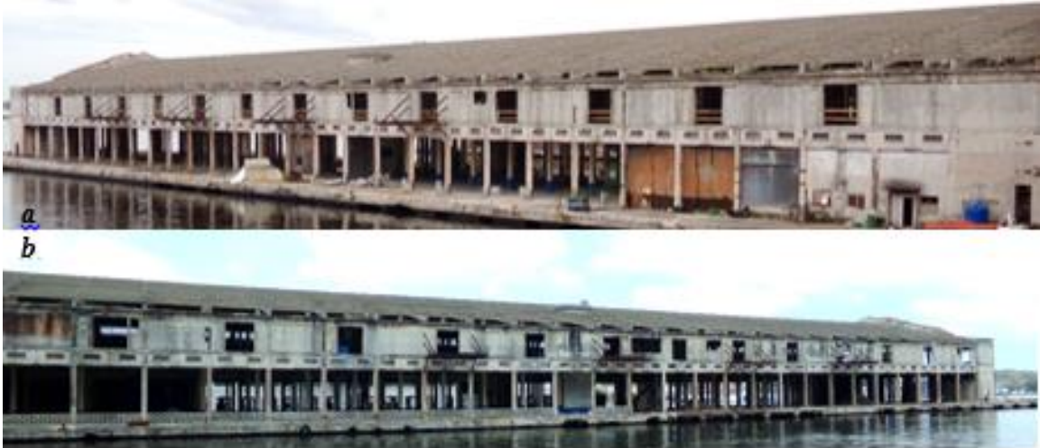
Figura 3.3 Aspecto actual de las fachadas. a: lateral norte y b: lateral sur. (Fuente: elaboración del autor)
