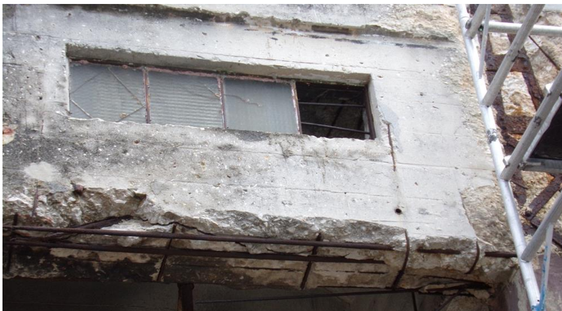
Figura 3.8 Aspecto actual del sistema de cierre del primer nivel. (Fuente: elaboración del autor)
