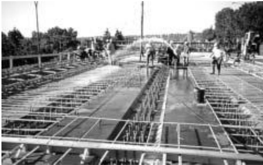
*Figura 1.1. PRFV instalados durante la construcción del Bridge Crowchild en Calgary, Alberta, Canadá.*
