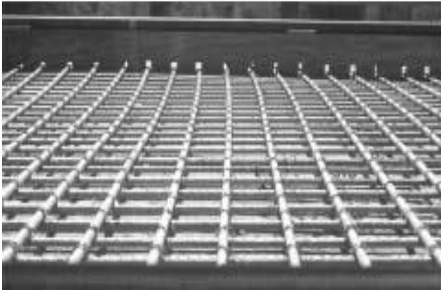
*Figura 1.3. PRFV usados en Sierrita de la Cruz Creek Bridge, en Amarillo, Texas, EE.UU, 2000.*
