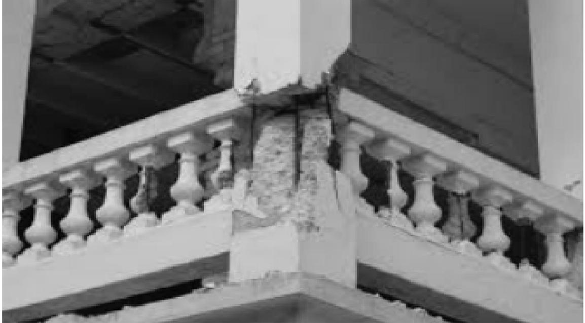
*Figura 1.4 Efectos de la corrosión de las barras de acero de refuerzo en edificaciones. (ARMOTEX, 2015a)*
