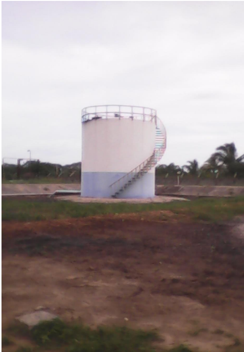
Figura. 2.7. Tanque Vertical de Techo fijo.
