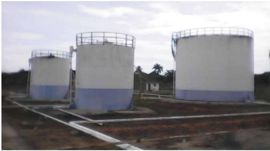
Figura. 2.5. Zona 2: Área de Almacenamiento y Control de rotación.
