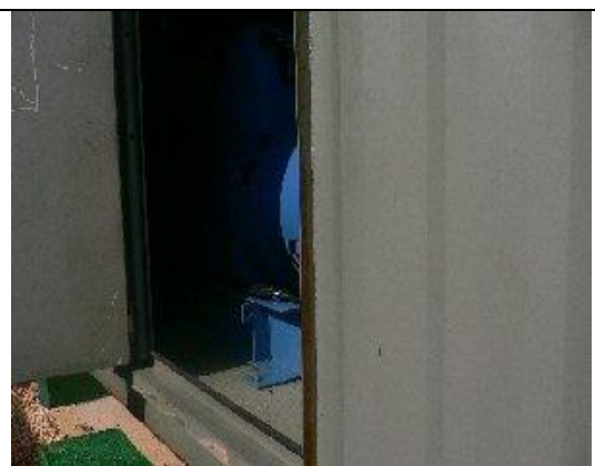
Figura 2.2 Área de difícil acceso
