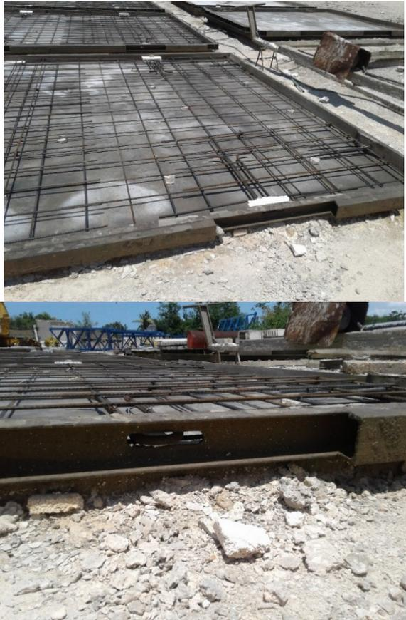
*Figura 2.8. Moldes y guarderas de las losas GP-IV (Confeccionada por la autora).*
