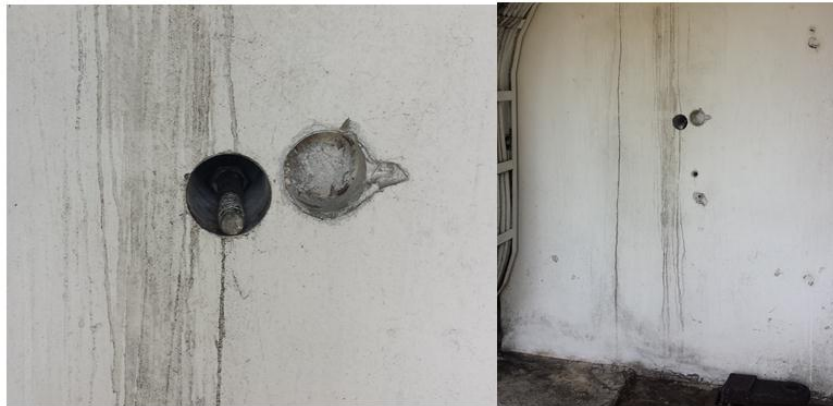
Fig. 2.2 Extracción de testigos en la base de la maquinaria.
