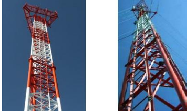
Figura 1.2. Torres autoportadas de sección triangular. (Vidal, 2011)
