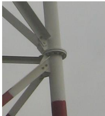
Figura 2.4 Unión columna-columna. (Fuente: Tomada por Patricia Martin)
