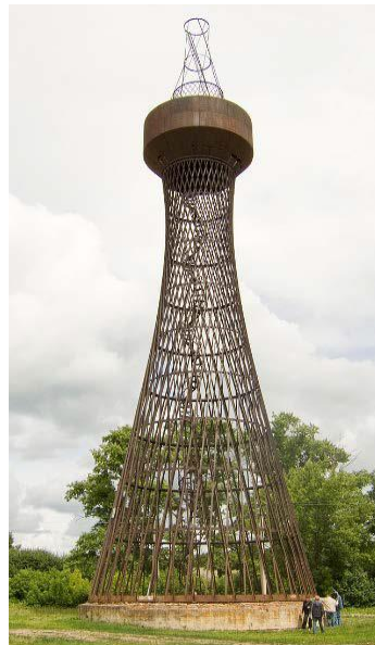
Figura 2.23 Torre de agua de Shukhov. [Khodadai & Buelow, 2014]
