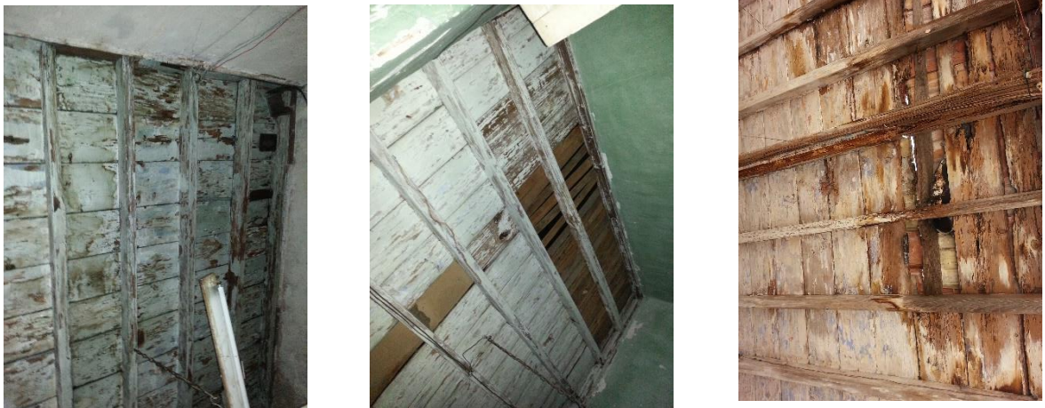
Figura 2.5: Estado cubierta alas exteriores y patio trasero. Fuente: Elaboración propia
