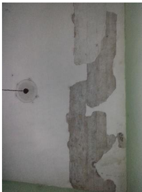
Figura 2.10: Desconchados del primer nivel. Fuente: Elaboración propia
