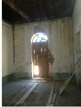
Figura 2.9: Humedades del segundo nivel. Fuente: Elaboración propia.
