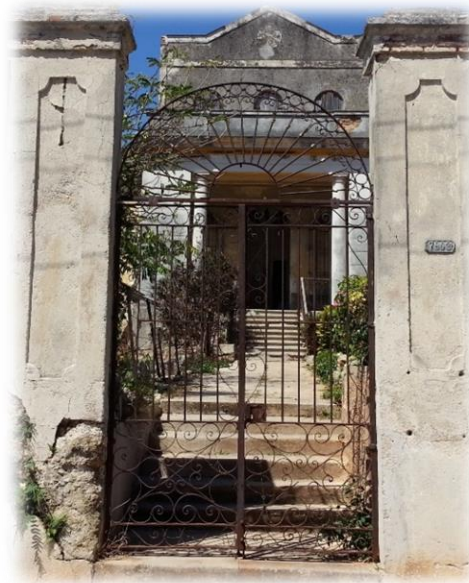
Figura 2.2 Acceso a la edificación, corredor intermedio. Fuente: Elaboración propia.
