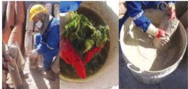
Limpeza y tratamiento de tejas antiguas, con agua de cal y penca
