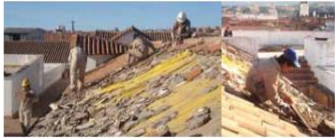
Retiro de tejas antiguas y eliminación de peso innecesario
