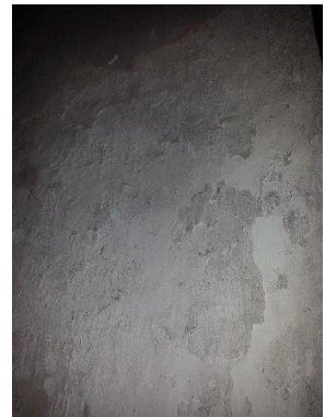
Figura 2.10: Desconchados del primer nivel. Fuente: Elaboración propia
