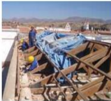
Refuerzo y nivelación de estructura original de madera
