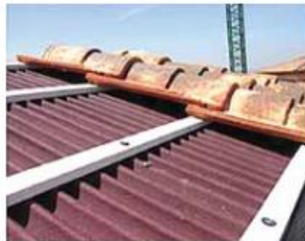
Sistema doble: calamina por debajo, teja antigua por arriba
