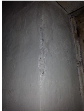
Figura 2.10: Desconchados del primer nivel. Fuente: Elaboración propia
