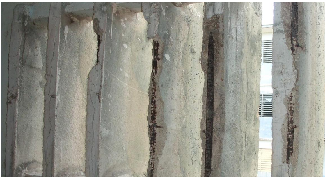
Figura 4: Recubrimiento en edificios multifamiliares de 28 de Octubre
