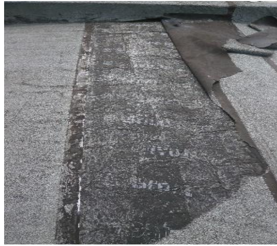
Figura 8: Impermeabilizante en edificios multifamiliares de 28 de Octubre
