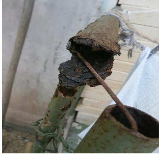
Figura 6: Barandales en edificios multifamiliares de 28 de Octubre
