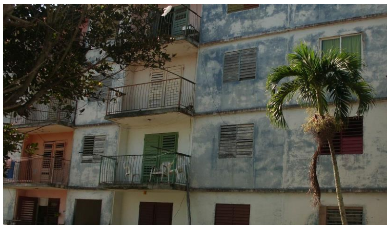
Figura 5: Fachada en edificios multifamiliares de 28 de Octubre
