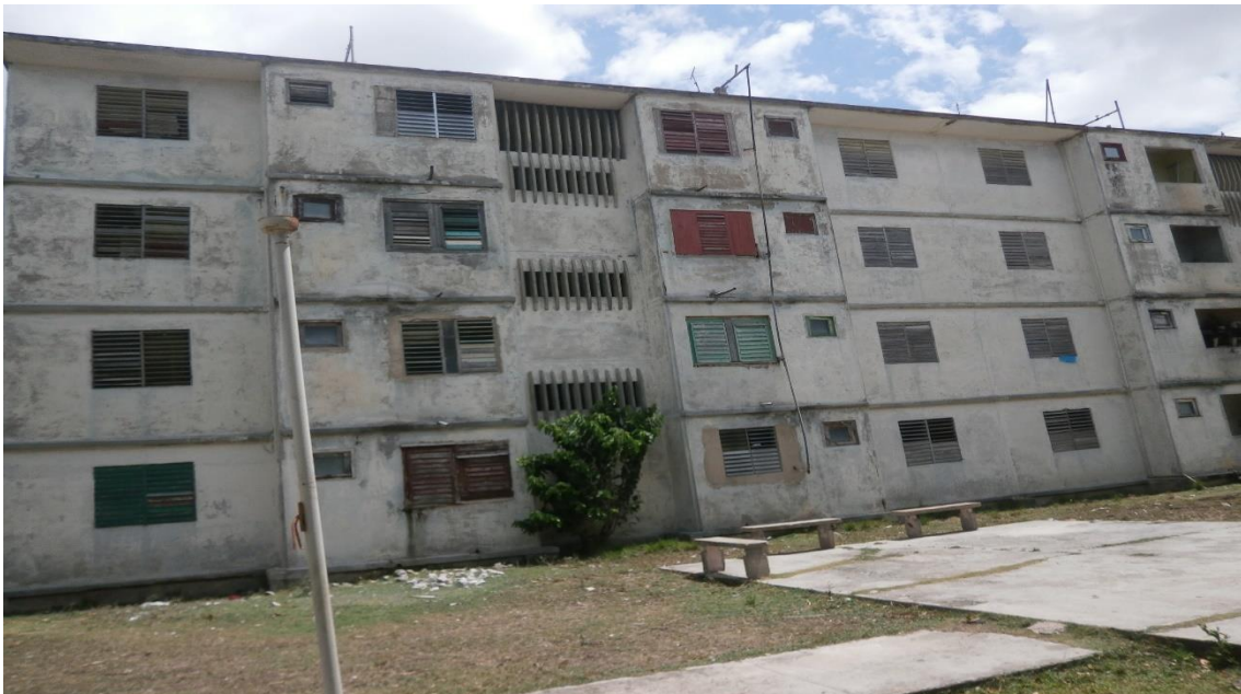
Figura 3: Edificios multifamiliares de 28 de Octubre
