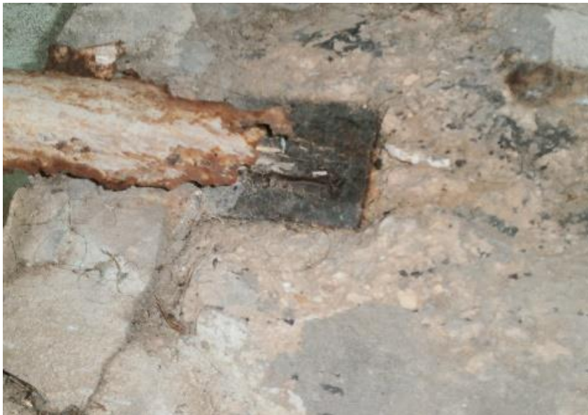
Figura 5: Barandales en edificios multifamiliares de 28 de Octubre
