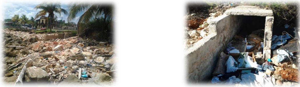
Figura 2.3. Alcantarilla No.3. Sector I. Estación 0+0.95
