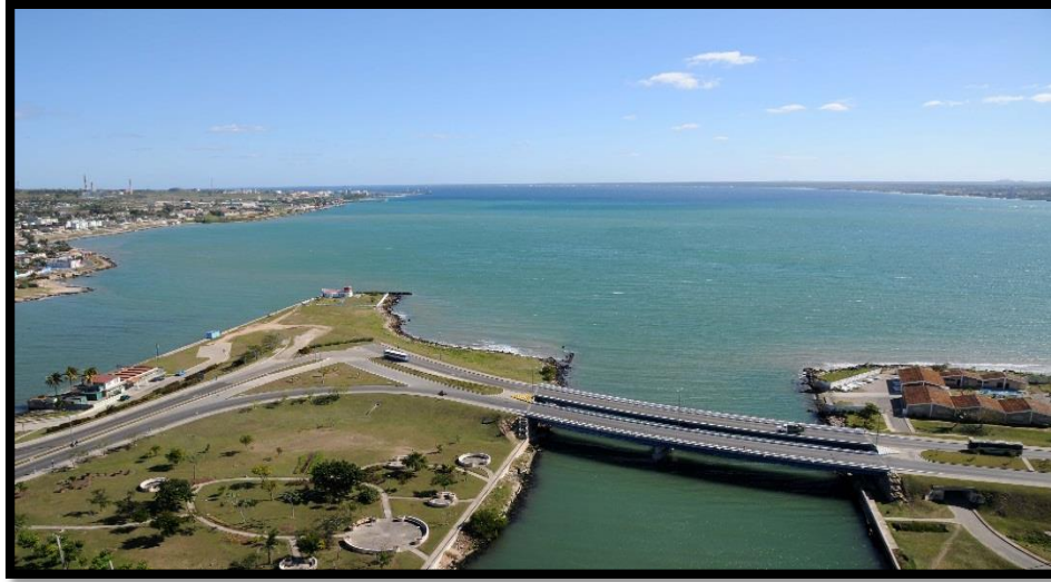
Figura 1.1.3: Puente sobre el río San Juan
