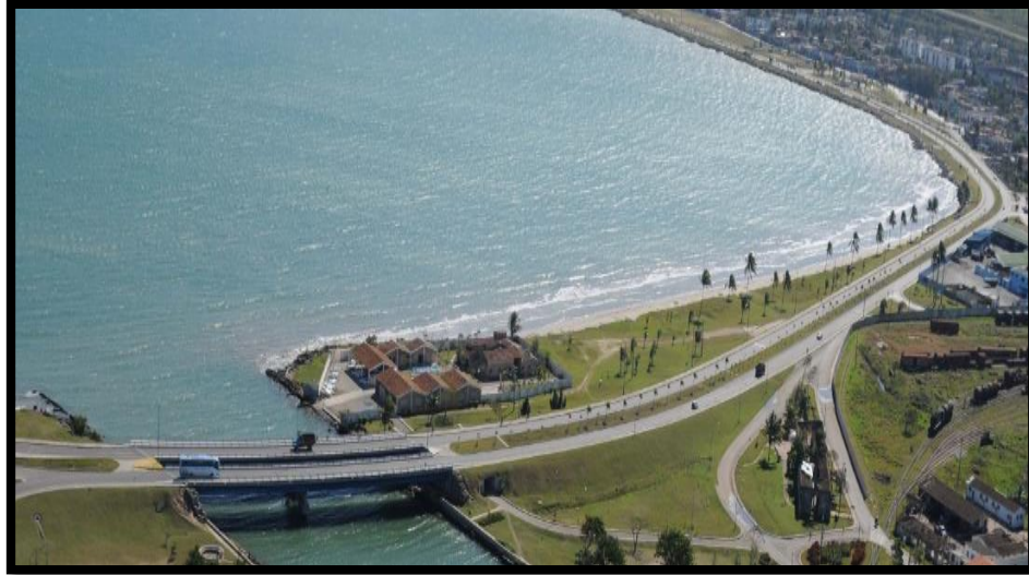
Figura 1.1.1.1: Viaducto de Matanzas.
