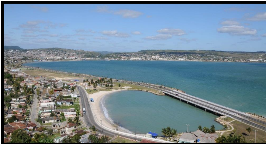
Figura 1.1.2: Puente del Viaducto El Tennis. Longitud 160m.
