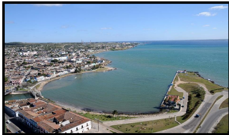
Figura 1.1.5: Vista aérea de la distancia a salvar por el tercer tramo del Viaducto
