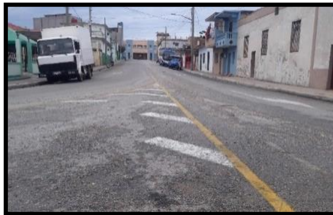
Figura 2.1.2: Calle Rieche en el barrio de Versalles en la ciudad de Matanzas
