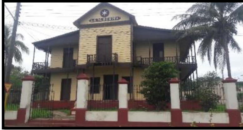
Figura 1.1.1: Vivienda de madera conocida como La Panchita frente a la cual comienza el primer tramo del Viaducto de Matanzas.
