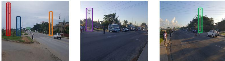
Figura 3.5- Tendido eléctrico y luminarias.
