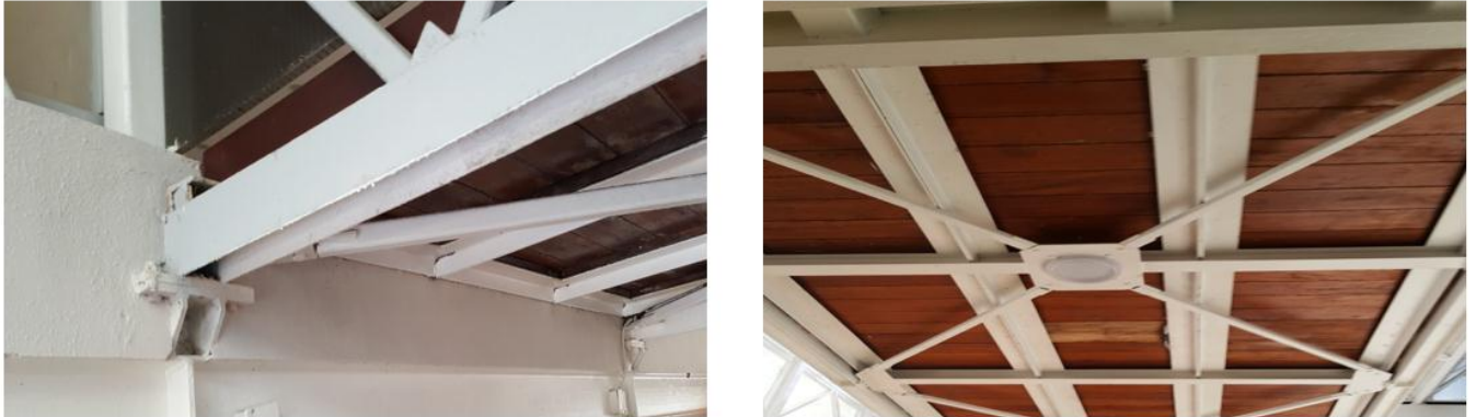
Figura 3.10- Tablero de acero estructural y madera:
