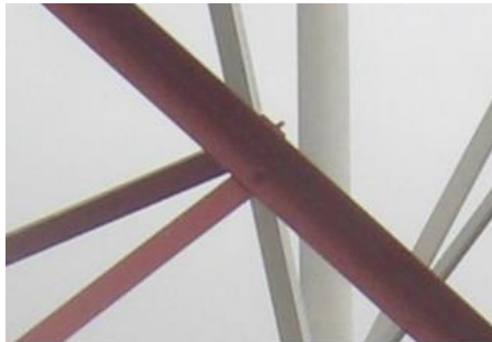
Figura 2.3 Unión diagonal-tranque.
