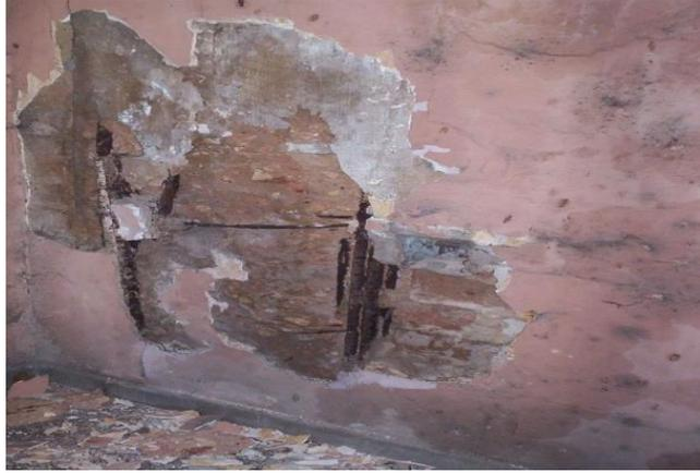
*Figura 3. Perdidas de recubrimiento y de sección de acero de refuerzo en las columnas. (Fuente: Informe de Patología: Hotel Velazco, ENIA (2008))*
