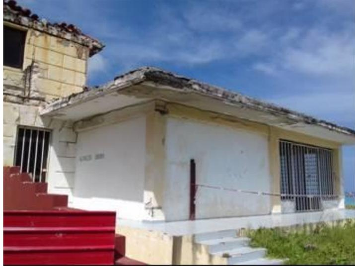
*Figura 2. Perdidas de recubrimiento y de sección de acero de refuerzo generalizado en la losa. (Fuente: Informe de Patología: Hotel Kawama, ENIA (2017))*
