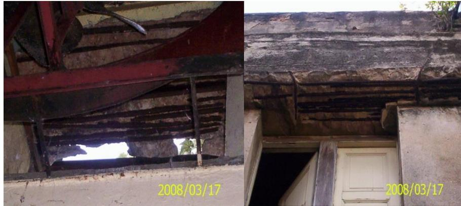
*Figura 5a y 5b. 5a: Fallo de la viga como elemento estructural, además de las pérdidas de sección tanto en el hormigón como el acero de refuerzo. 5b: pérdidas de sección tanto en el hormigón como el acero de refuerzo de manera localizada. (Fuente: Informe de Patología: Hotel Velazco, ENIA (2008))*
