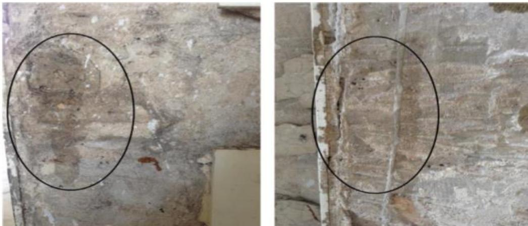
*Figura 2. Presencia de carbonato en las columnas donde se realizó el ensayo.*
