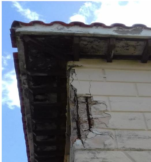
*Figura 4. Perdidas de recubrimiento y de sección de acero de refuerzo en las columnas. (Fuente: Informe de Patología: Hotel Kawama, ENIA (2017))*
