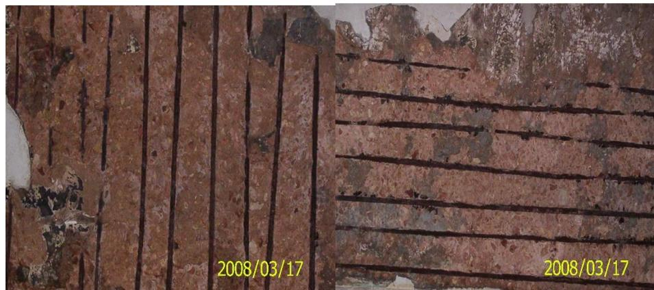
*Figura 1. Pérdidas de recubrimiento y de sección de acero de refuerzo generalizado en la losa. (Fuente: Informe de Patología: Hotel Velazco, ENIA (2008))*
