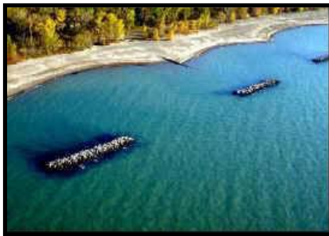
Figura 1.3 Diques exentos paralelos a la línea de orilla.
