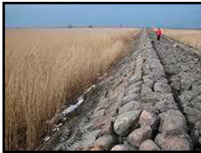
Figura 1.1 Diques de contención en Ainaži (Letonia).
