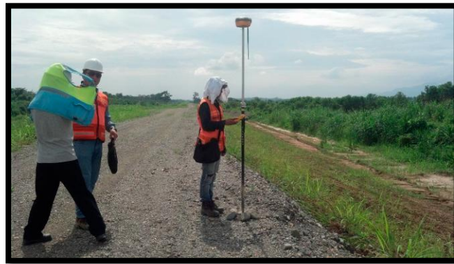
Figura 2.5: Medición de asentamiento con GPS diferencial.
