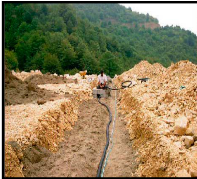
Figura 2.7: Instalación de una celda de asentamiento
