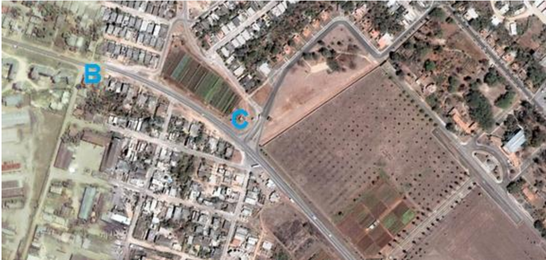
Figura 3.3 Sector #2 B: Emsuna-C: Intersección (Carretera Central-Estado Mayor, Hospital Militar)
