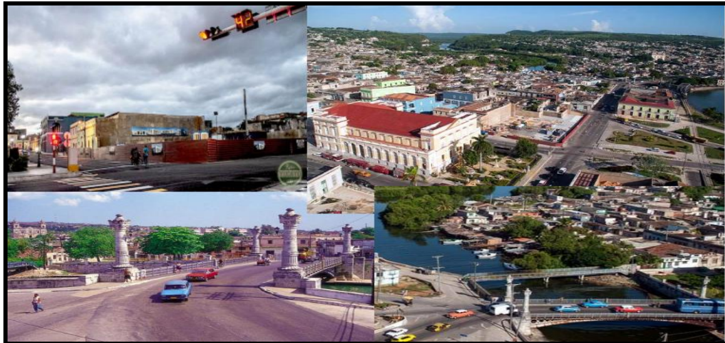
Figura 3.3 Situación del nudo de Ayllón (arriba) y puente La Concordia (abajo).
