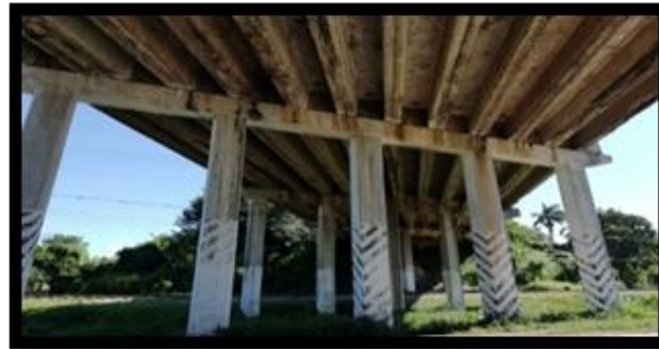
Figura 2.2: Vista de las vigas y elementos de apoyo. (Elaboración propia)
