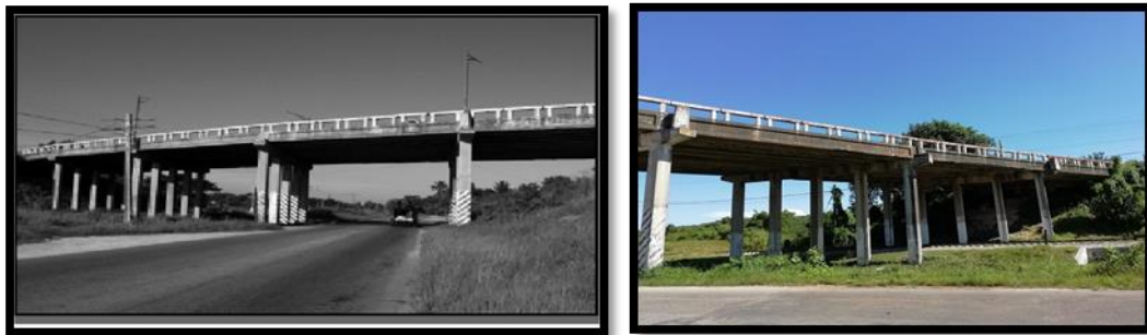
Figura 2.1: Vista longitudinal del Puente del Paso Superior de la Circunvalación de la ciudad de Matanzas en el 2009 y en la actualidad. (Elaboración propia)
