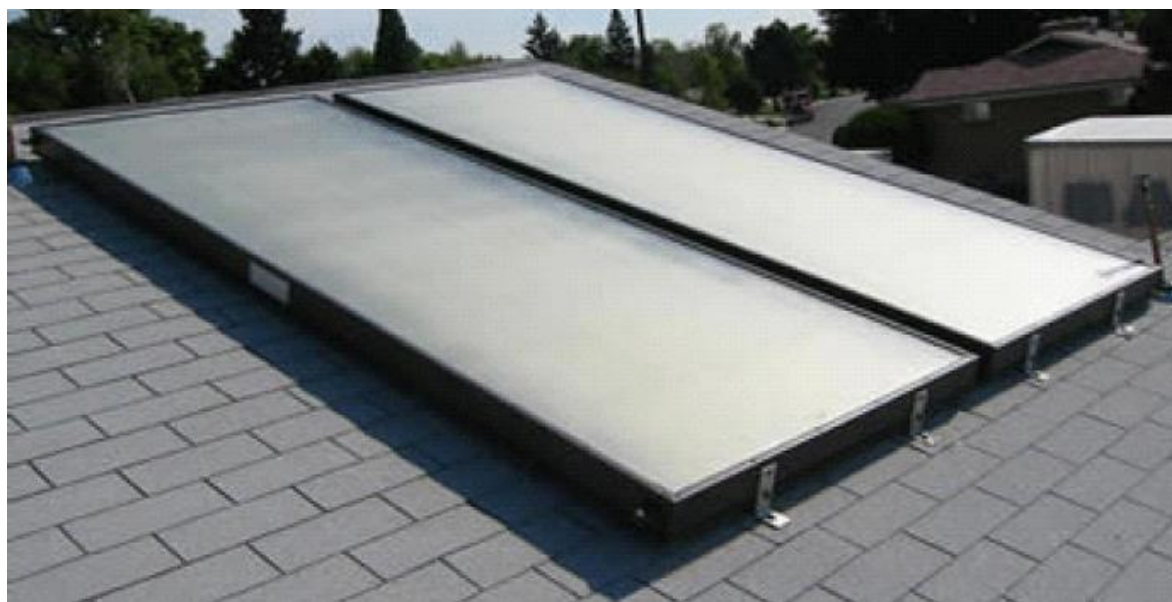
Figura 1.2 Foto de colector con placa plana con cubierta.
