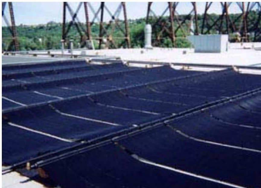
Figura 1.4 Foto de Colector de placa sin cubierta
