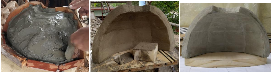
Figura 3.2. Fundición, resano y colocación en la base de madera de la concha acústica. Fuente: elaboración propia.
