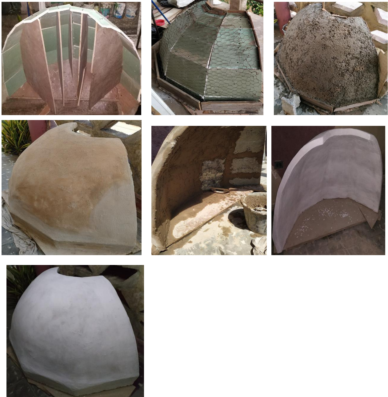
Figura 3.5. Proceso de construcción de la concha acústica a escala 8:100. Fuente: elaboración propia.
