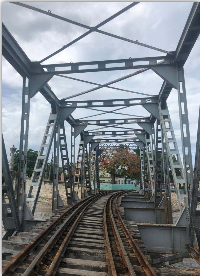
Figura 2.7 Diagonales superiores y vigas transversales superiores. Fuente: Elaboración propia.
