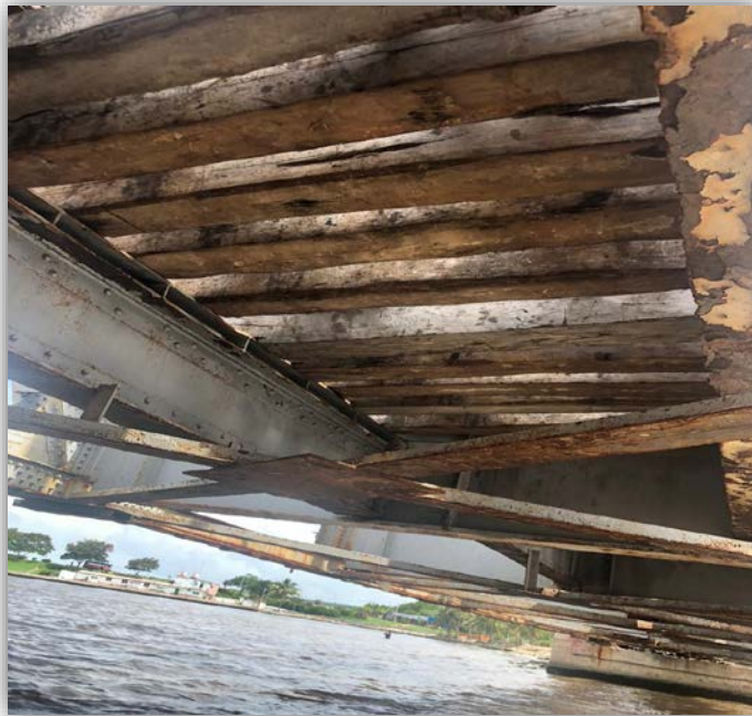
Figura 2.8 Diagonales inferiores. Fuente: Elaboración propia.
