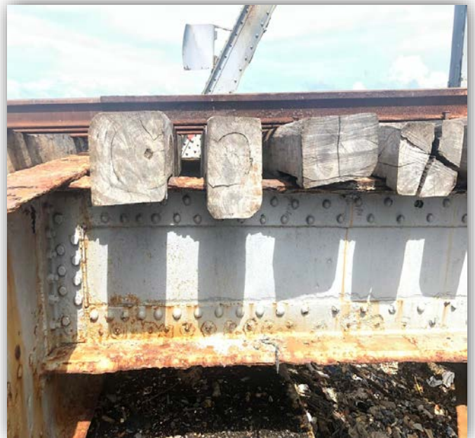
Figura 2.11 Raíles y traviesas de madera del Puente Dubrocq. Fuente: Elaboración propia.
