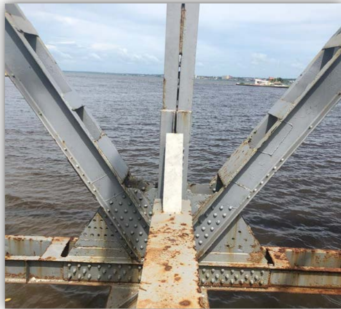
Figura 2.4 Viga transversal inferior. Fuente: Elaboración propia.
