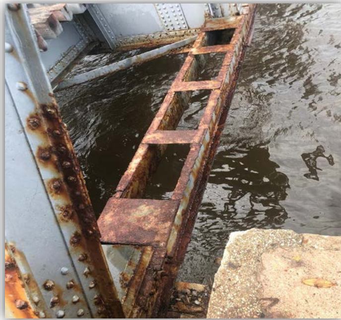
Figura 2.5 Viga cordón inferior. Fuente : Elaboración propia.
