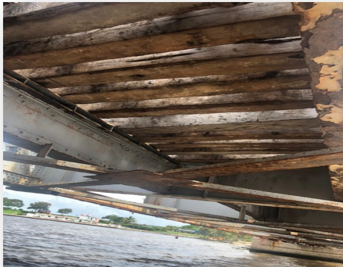
Figura 2.3 Vigas longitudinales del puente Dubrocq. Fuente:
