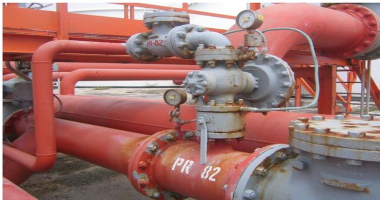
Figura 2.8 Proporcionador de espuma PR-82
