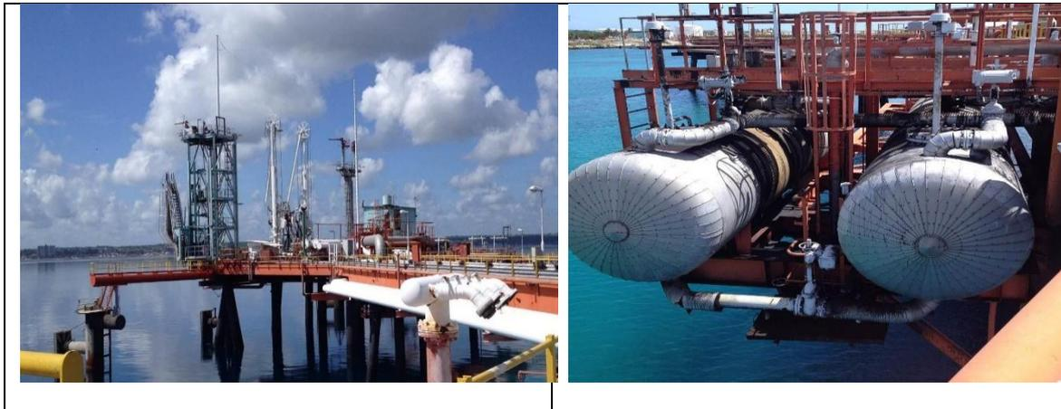
Figura 3.3 Tanques de Slop de la plataforma (PC 2)
