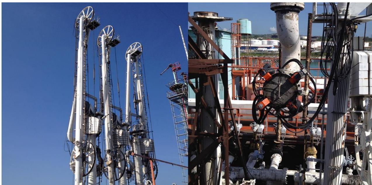
Figura 3.7 Brazos de carga/ Sistema de acople de muelas mecánicas JLA en muelle PC-2.
