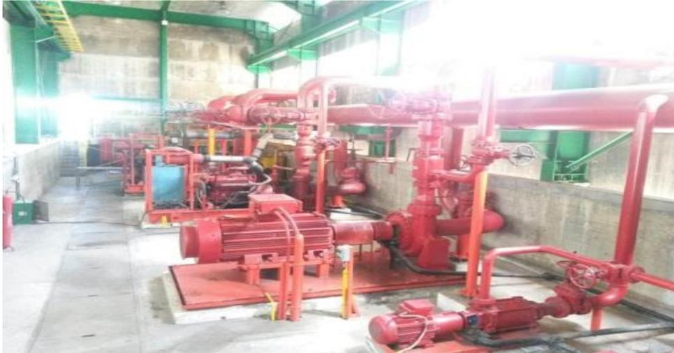
Figura 3.9 Bombas de agua para el sistema de PCI de los muelles.
