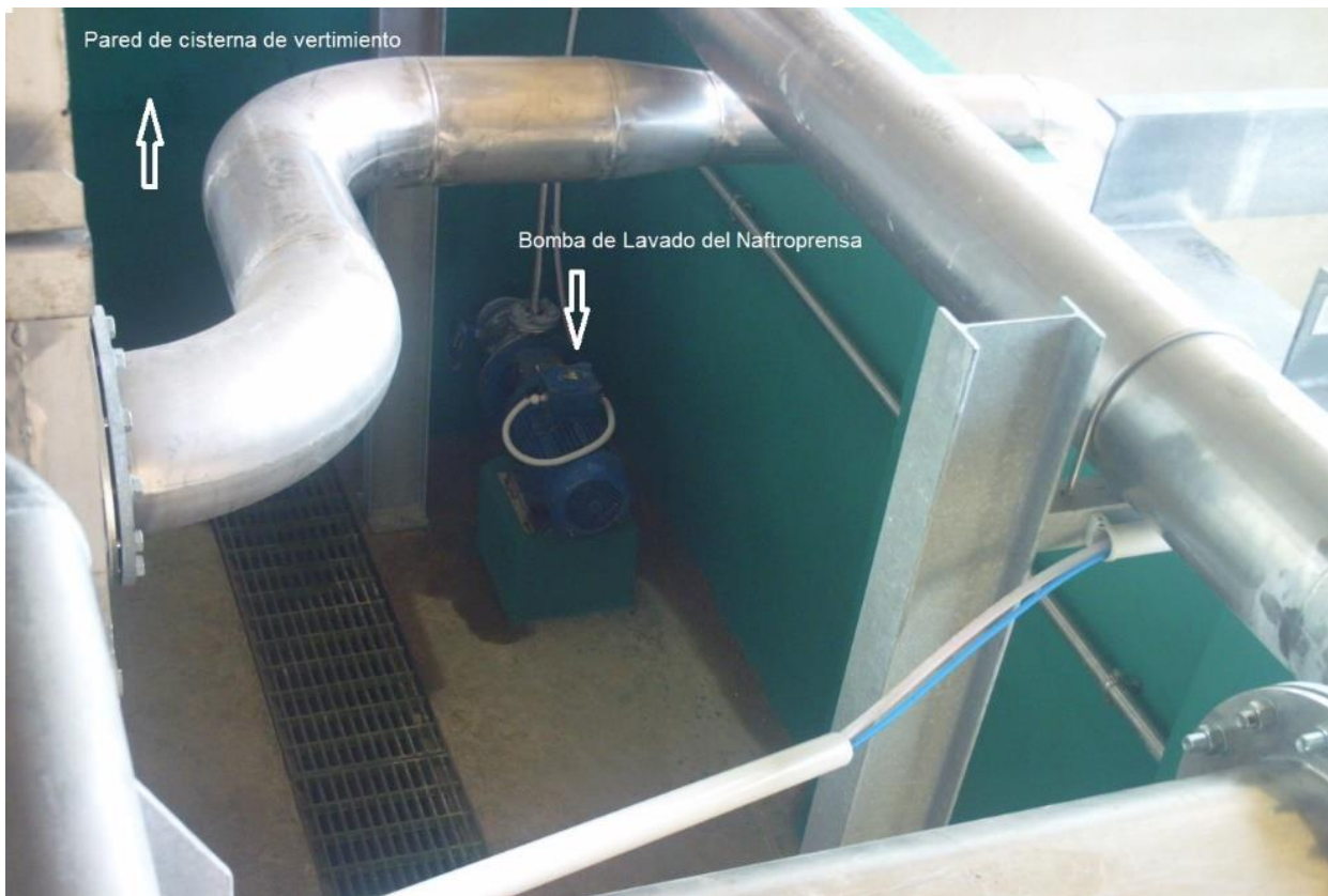
Figura A.5. Bomba RS4 40-18 CR020 15 Fuente: Elaboración Propia
