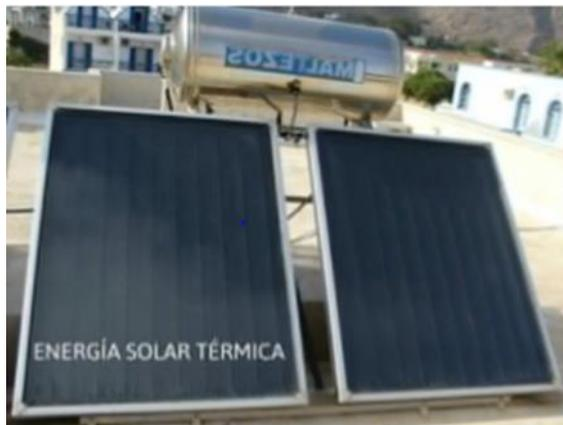
*Figura#2: Calentador Solar Plano. Fuente: Cubasolar*
