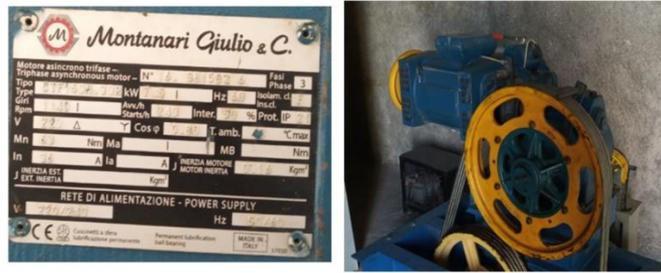
Figura 2.5 Datos de la chapilla del motor del elevador (elaborado por el autor)
