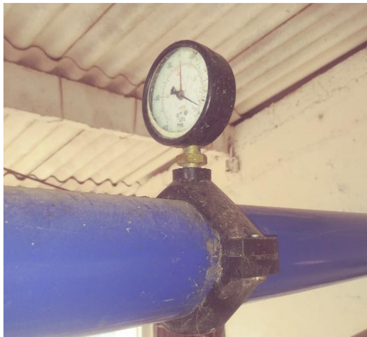
Figura 2.5 Vacuómetro. (Fuente propia).
