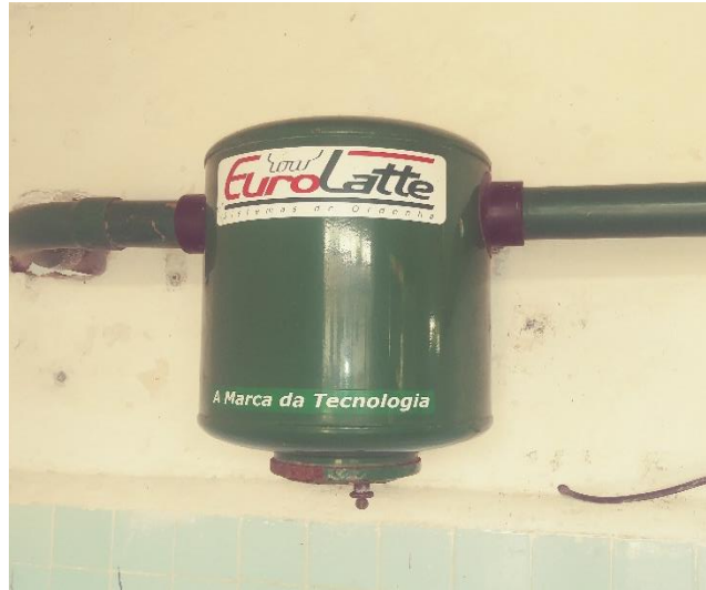
Figura 2.3 Balde trampa. (Fuente propia).
