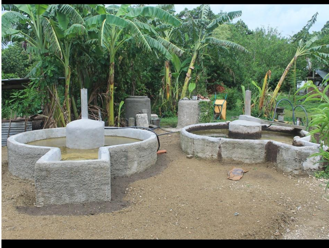
Anexo 11. Biodigestores en serie para la producción de biogás y fertilizantes.
