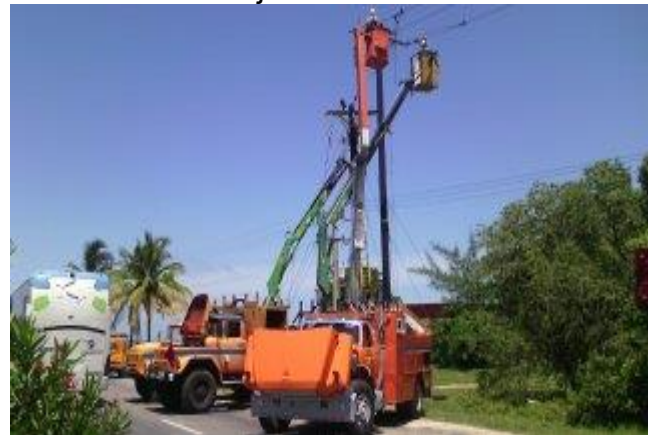
Foto No 4: Cambiando un poste de una línea eléctrica aérea junto al área de parqueo de un hotel, ocupando la vía, los capós de los camiones abiertos, etc. Al frente el loby del hotel y al fondo la playa.
