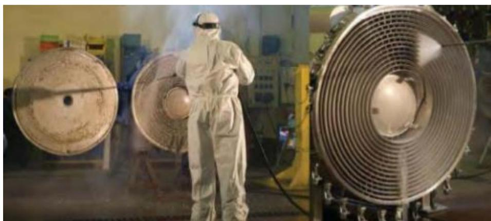
**Figura 1.8 Limpieza mecánica. Fuente:** (AlfaLaval, Manual de instalación, funcionamiento y mantenimiento Intercambiador de calor espiral, 2016)
