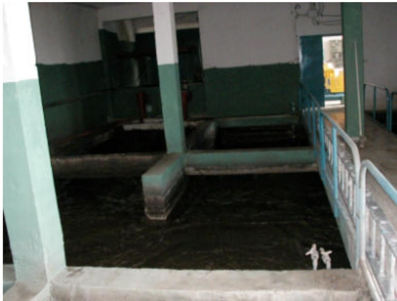
Figura 4.5. Imagen de dos de las tres secciones del reactor biológico.
