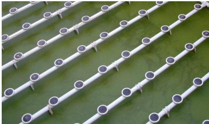
Figura 4.7. Red de tuberías y difusores del sistema de aireación del reactor biológico.
