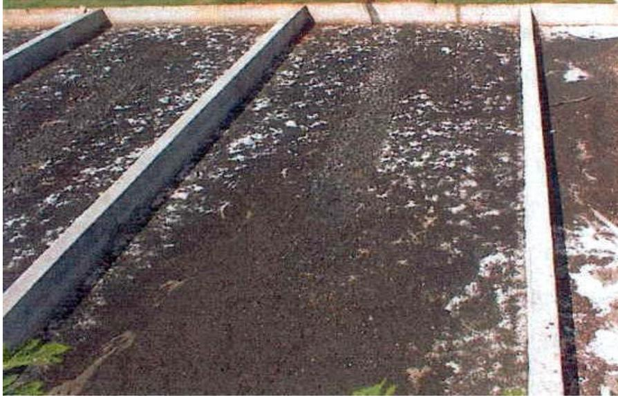
Figura 4.9. Lechos de secado de lodos.
