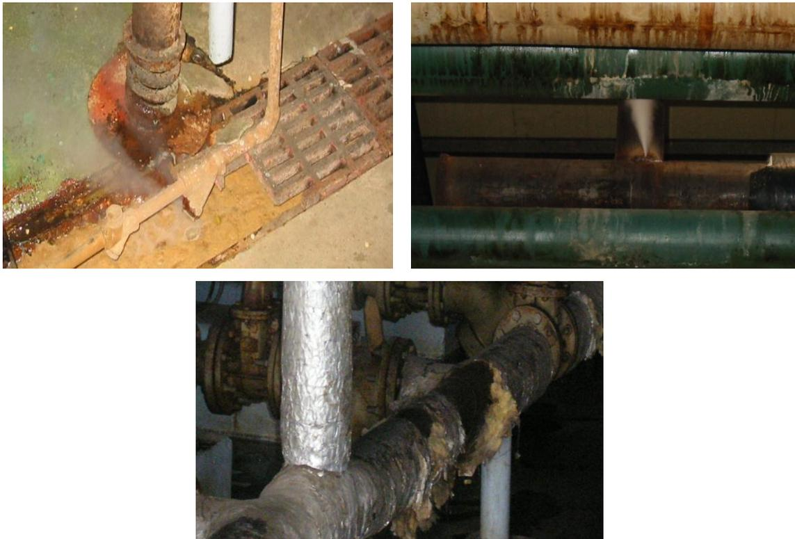
Figura 3. Problemas que se presentan con fugas de vapor y aislamiento de tuberías
